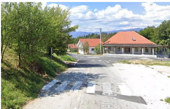
7. Prehod za pešce v bližini krožišča
