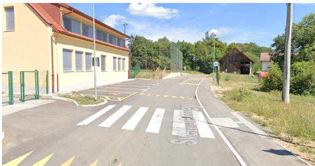
4. Prehod za pešce pri šoli Jernej
